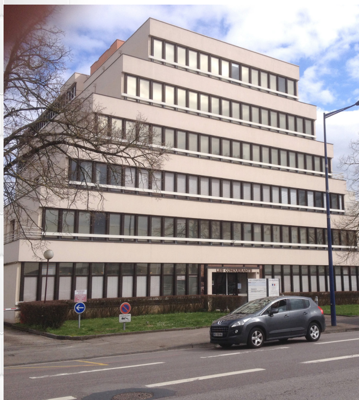
Siège de la CRPV à Metz
